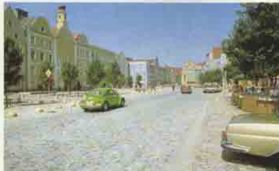
Platz an der Sonne Moderne Verkehrstechnik: Dies ist das Dach einer Tiefgarage. Weil der Platz an der Sonne für die Bürger wichtiger ist als für die Autos.
