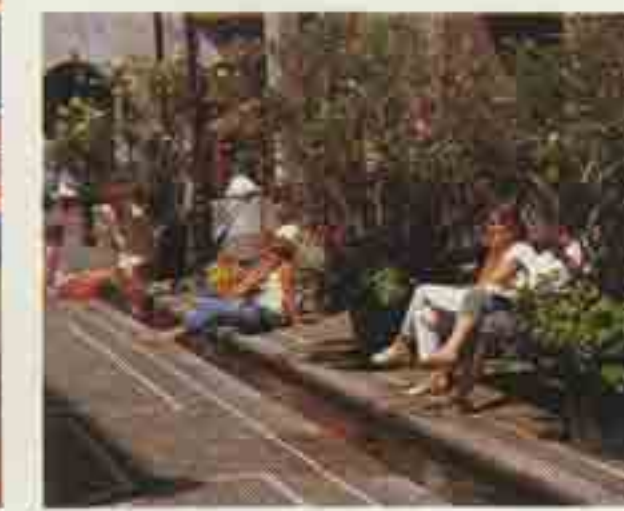
Straßengraben. Gleichzeitig Hochwasserüberlauf. Gestaltete Technik.
