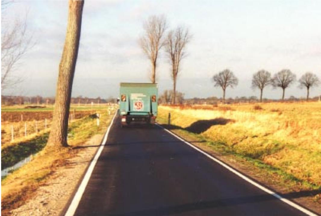
Abbildung 13: Verbindungsstraße bei Oebisfelde mit kostenreduzierenden und nutzungsangepassten Standards durch Auslegung für geringe Geschwindigkeiten und Abbremsung bei (seltenen) Begegnungsfällen.
