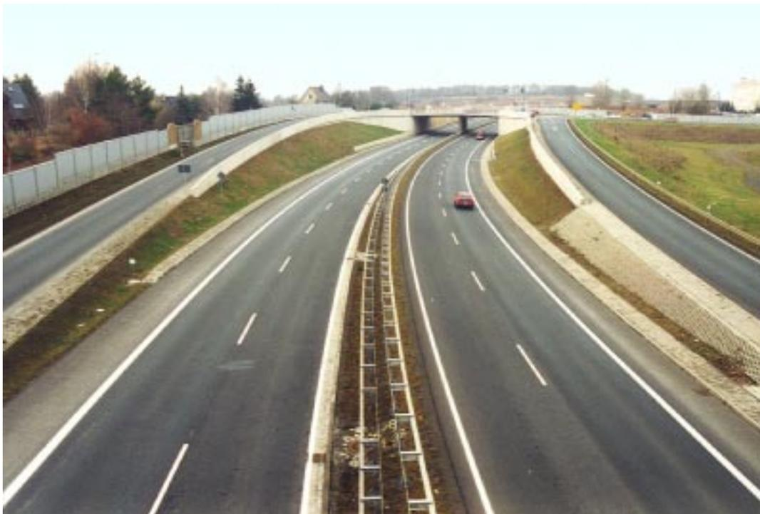
Abbildung 14: Immerhin flächensparende Parallelrampen im Zuge der Ortsumfahrung B 91 Weißenfels, die bei der verwendeten Anordnung Beschleunigung und Verzögerung unterstützen. Quelle: Eigene Darstellung
