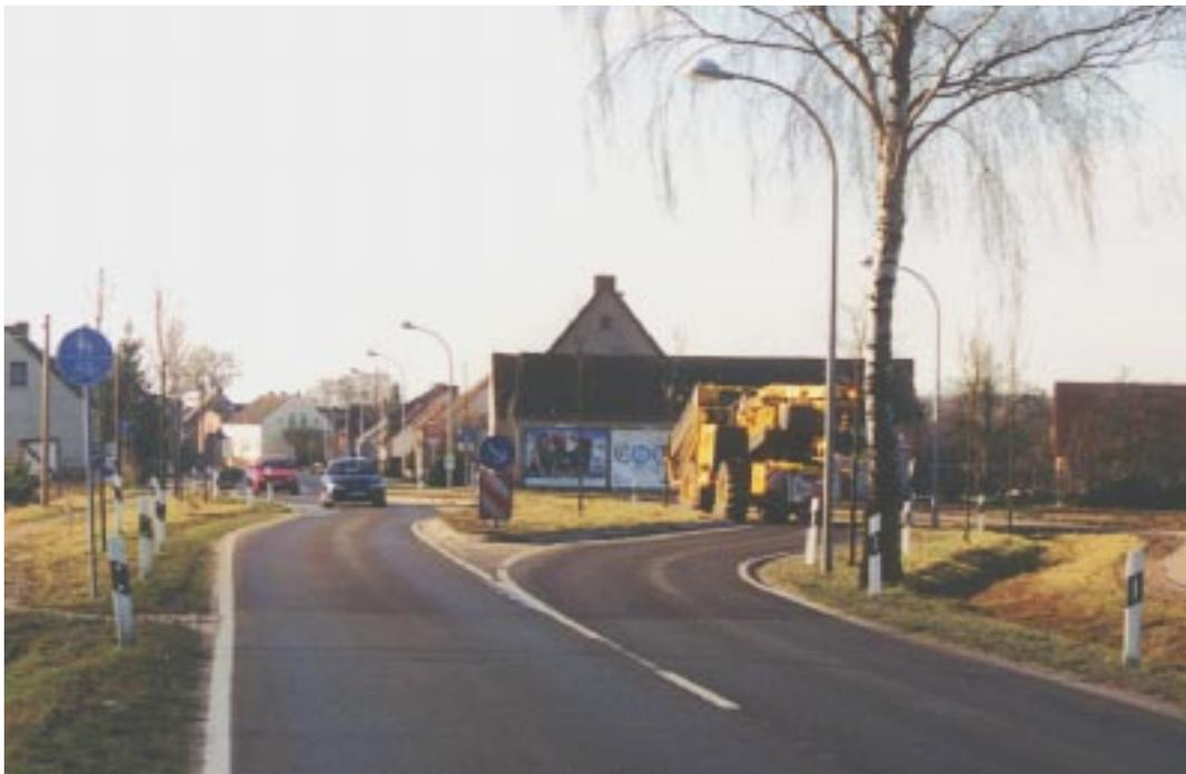
Abbildung 17: In Solpke soll eine schikanöse Spurverschwenkung am Ortseingang die Kfz-Geschwindigkeiten vermindern, jedoch geht dahinter die Fahrbahn ohne ausformulierten Unterschied bezüglich Breite, Oberflächenbeschaffenheit und Eingrenzung weiter. Lärmbelästigung durch erneutes Beschleunigung ist garantiert. Quelle: eigene Darstellung
