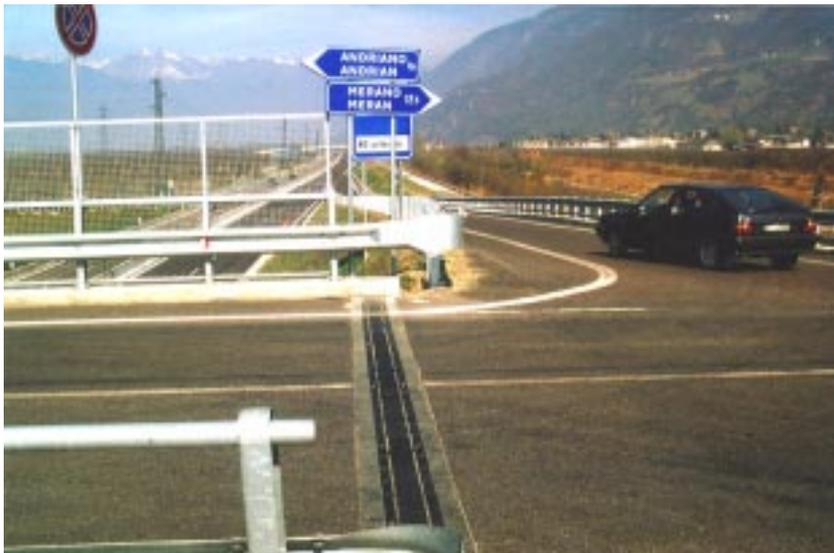
Abbildung 5: Straßenverbindung Bozen - Meran mit häufigen, kurzen und schmalen Parallelrampen; Brücken zweispurig ohne Abbiegeflächen; kleine Schilder.
