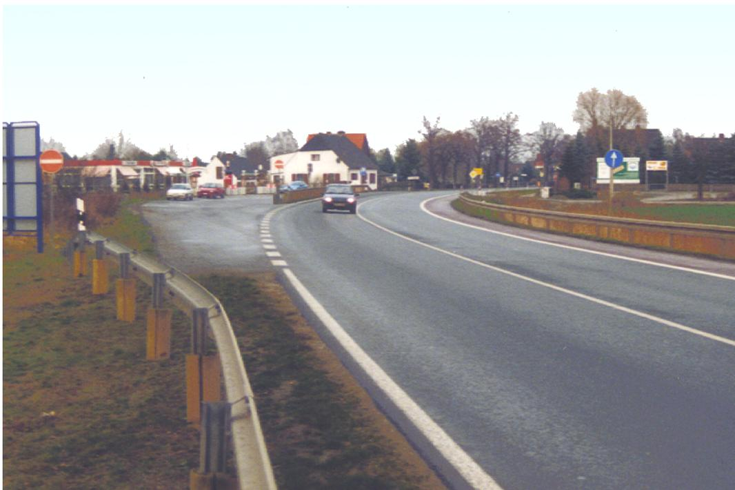
Abbildung 19: Am Ortseingang Gerwisch wurde die B 1 verbreitert und der Kurvenradius vergrößert gegenüber dem früheren Straßenverlauf links im Bild. Damit jetzt noch schneller in das Dorf eingefahren werden kann. Quelle: eigene Darstellung
